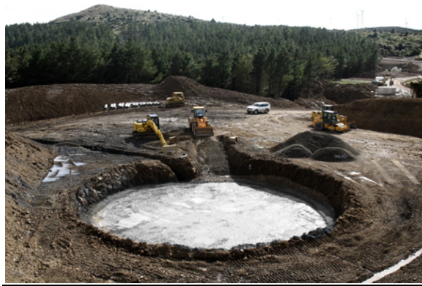
Costruzione di un basamento cementizio per pala eolica
