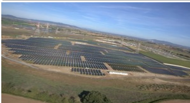
Impianto Industriale Fotovoltaico di Montalto
